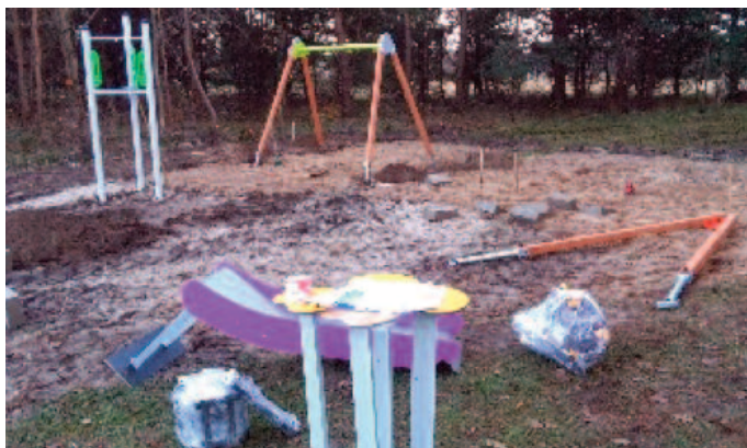
fot. Budowa placu zabaw
