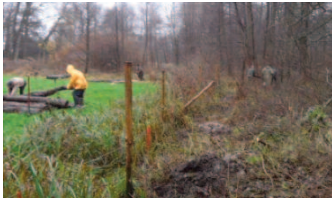
fot. Stawianie ogrodzenia w Parku nad Rzeczką
