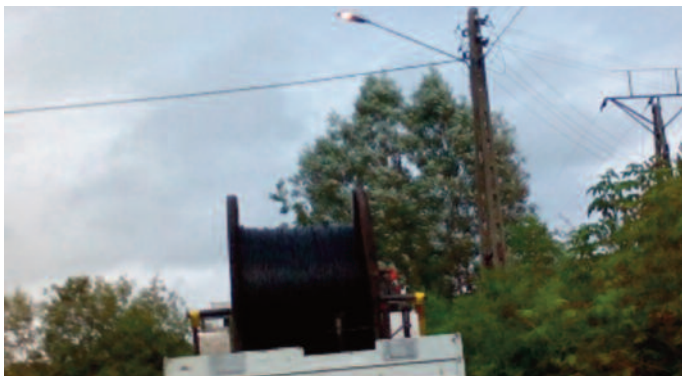
fot. Montaż lamp
